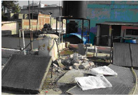
Foto 6. Colector realizado sin punzón. La foto la tomé cuando estaba haciendo algunos cambios, por eso se ve material de construcción.
