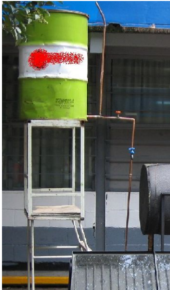
Ejemplo de tanque de alimentación
