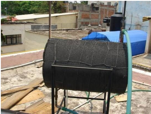
Foto 9 Termotanque sellado de lámina negra forrado con neopreno esponjado amarrado con rafia.
