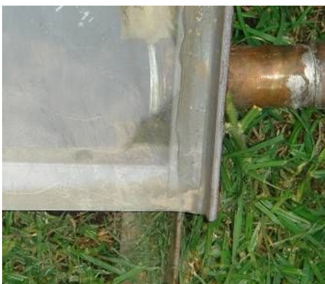
En la foto se ve el vidrio colocado y no se alcanza a notar el silicón ya que es transparente.
